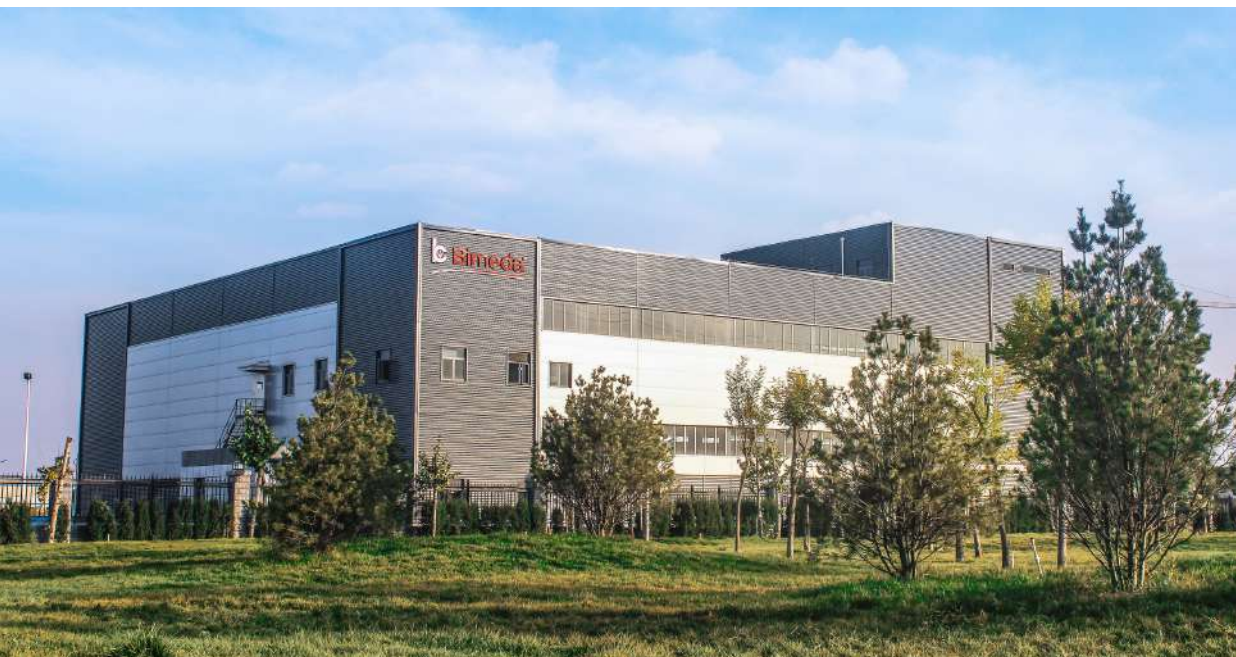
Site de Bimeda à Shijiazhuang, Hebei, Chine
